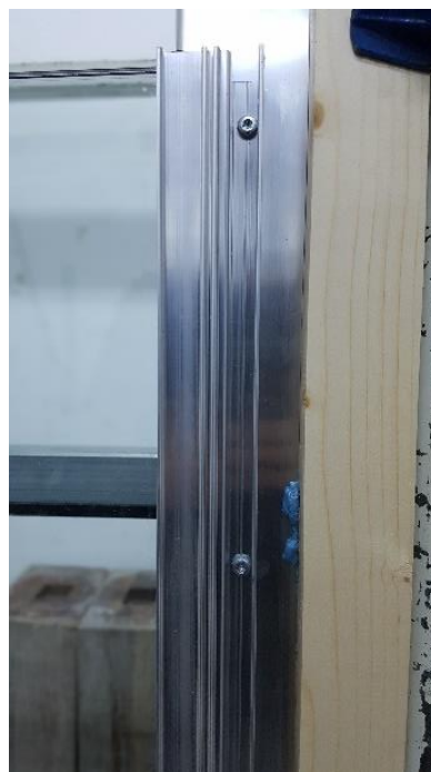
Distancia de 200 mm entre tornillos (7 uds)
