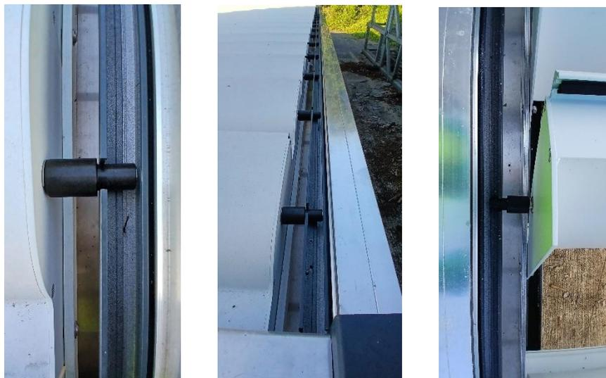
*Detalle conexión de lama con viga longitudinal*
